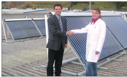
María Victoria Castillo Sainz Rozas, responsable de Medioambiente y Calidad de la empresa, junto con uno de los responsables de la instalación solar
